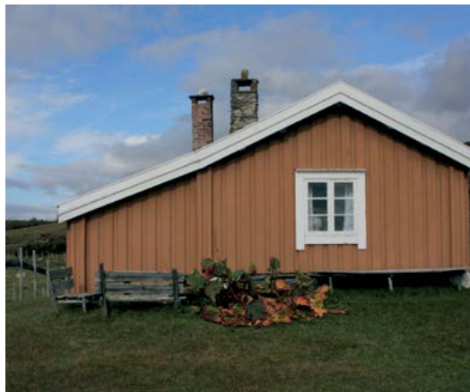
På Strømsøyvangen er det to piper, ei gammel gråsteinspipe, og ei murt teglpipe fra ca 1955.
