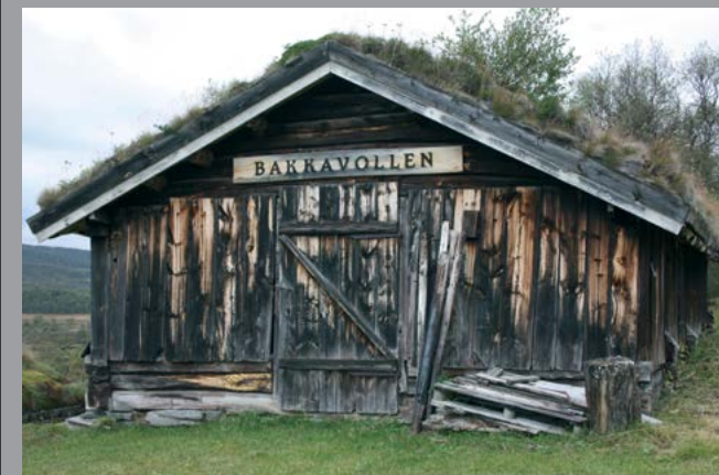
Bordfjøs med grovt bindingsverk i Mastukåsen, Vangrøftdalen
