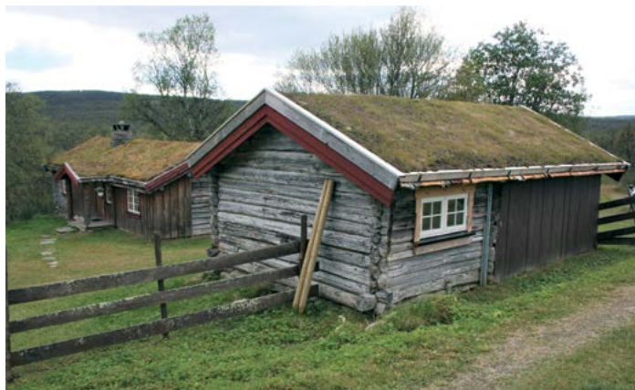
Et jevnt, og nøkternt utført vedlikehold er ofte det beste!
