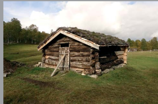
Fjøset på Bruavollen i Synnerdalen er restaurert og har fått nye vindskier i tråd med de gamle.
