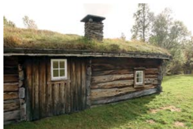
Gluggen plassert med ulik høyde på vegg.
