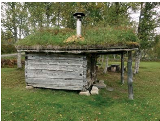
I løer og små uthus er det ikke så vanlig å mure oppunder mellom holdsteinene.
