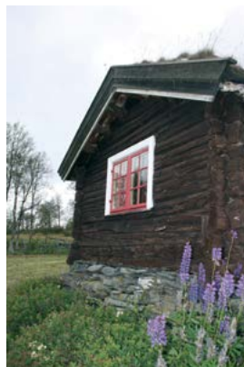
Holdsteinsmur på seterstue. Her er det holdsteinene som bærer tømmerkonstruksjonen.
