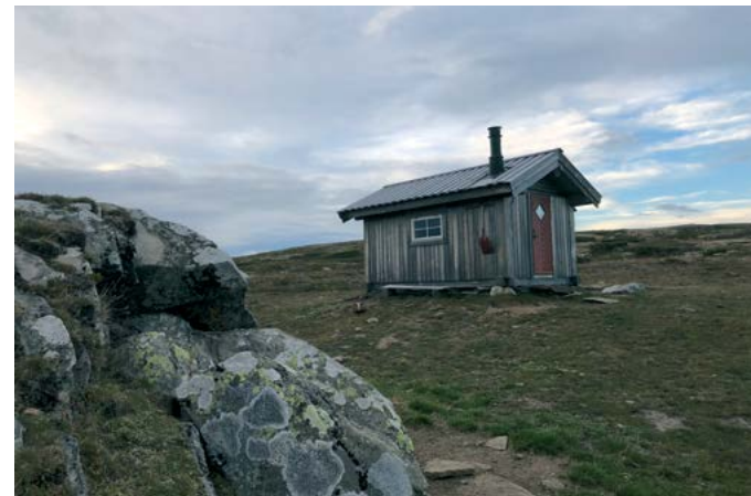
De fleste buene er små og enkle. Denne relativt nye bua ved Eventjønnoen i Vingelen, erstattet ei tidligere.
