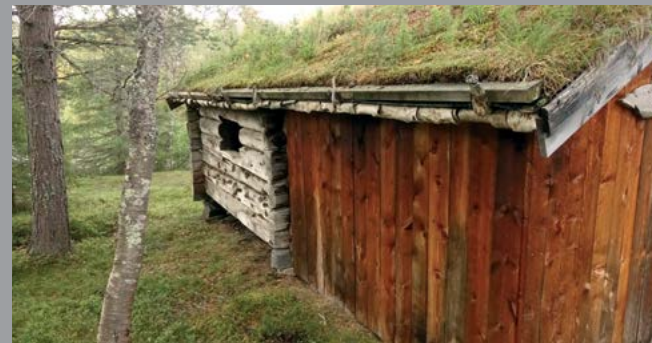
På Museumssetra i Synnerdalen er taket både på et fjøs og ei seterstue tekket om med bruk av einerkroker, torvhall og never som dekker takkanten. Grunnmursplaten er skjult så godt det lar seg gjøre. Takutstikket er bare 15-20 cm. Vindskiene er smale og uten dekor.
