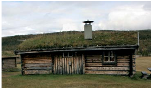
I denne seterstua på Hiåvolla i Endalen er det satt inn ei pusset elementpipe.
