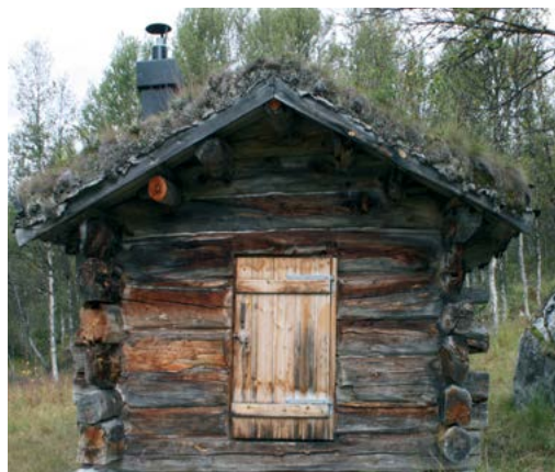
Slåttebua i Nygardsenget i Vingelen, har bare ei vindskie, noe som er vanlig på uthus.
