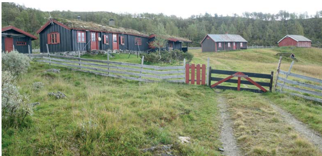
Seterstue på Langsåvollen i Båttjønndalen har fått ny kledning og flere tilbygg.
