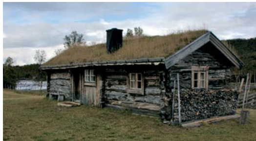
På ei anna seterstua på Hiåvolla i Endalen er det brukt pipe med stålbeslag.
