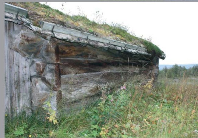
På Øvre Tollefsvollen i Vingelen står det et fjøs som har kun fire stokker i langveggen. Stokkene er kløvd for å utnytte tømmeret best mulig. (Se beskr. s. 10)
