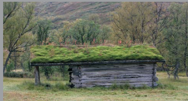
Løe med ekstra stort takoverbygg forran inngangen (ca 3 m). Blåola i Endalen
