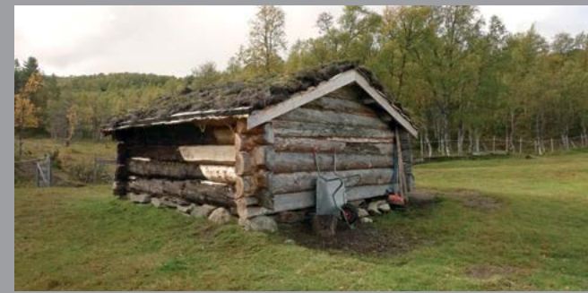
Reparasjon av tømmervegg, Bruavollen i Synnerdalen
