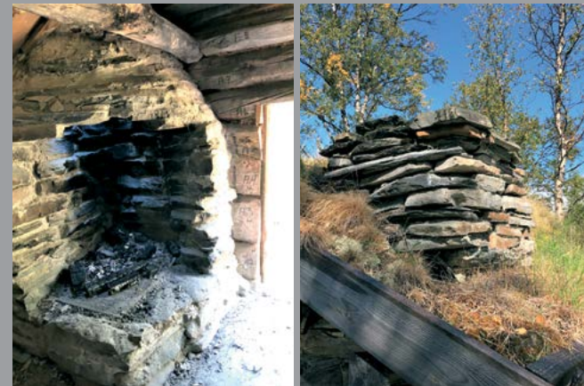
Murt grue og pipe i Olderbua i Sølendet, Røros
