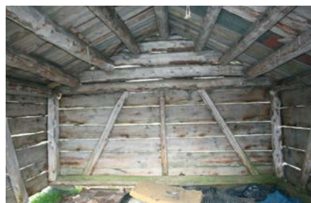
Skjelterkonstruksjonen er en materialbesparende byggemetode og er mye brukt i både fjøs, løer og andre mindre bygninger. Her er det brukt liggende panel, men som oftest er det brukt stående panel. (Se s. 33)
