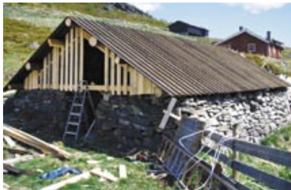
Arbeidet med fjøstaket på Strø i Vestre Slidre er fullført.
