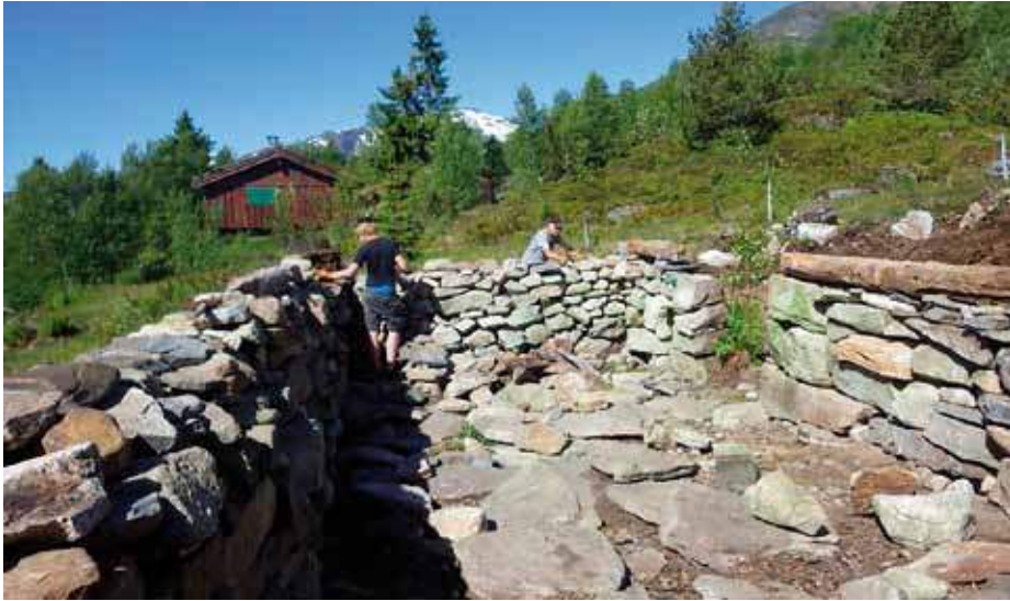
Muren er komen opp, men det gjenstår justeringar når tømmeret vert lagt på.
