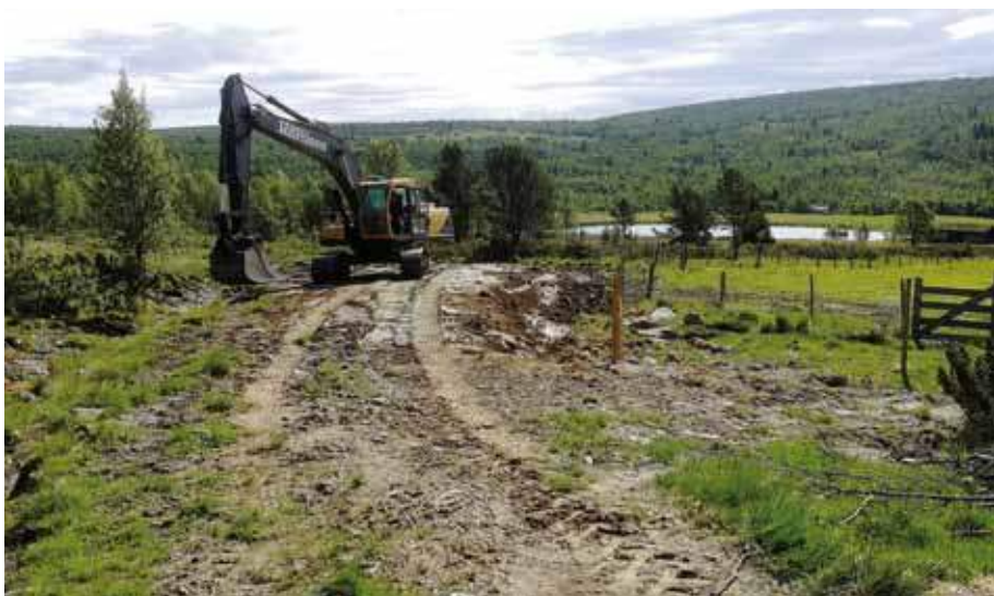
Samletrø med veg til beiter. Vegen er oppbygd med stein som er kjørt av jordene. I samletrøa er det fylt på med grov flis oppå. Foto: Olav Østigård.
