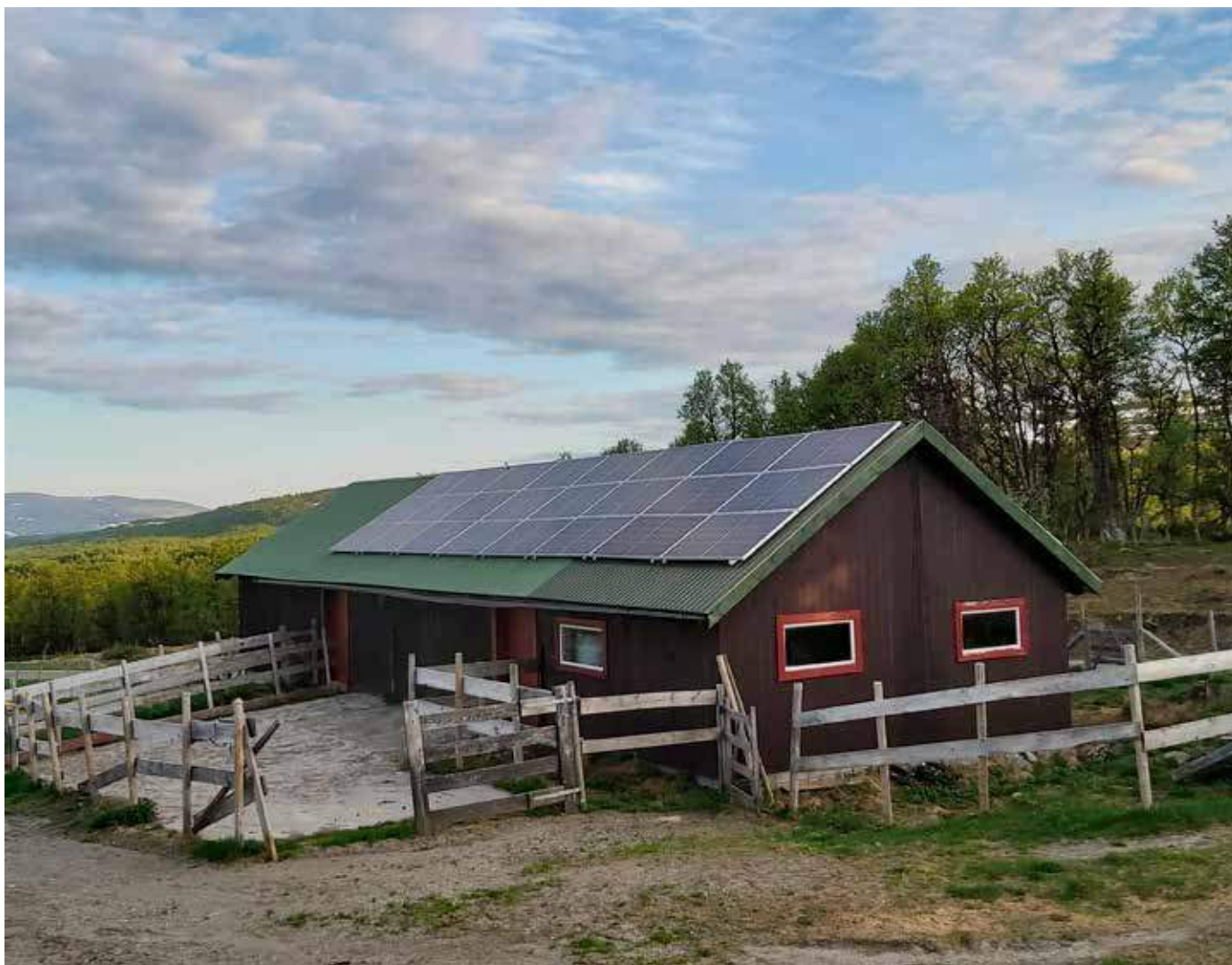
Solcellepanela kom på plass på setertaket alt i oktober 2019 (bilete: Erling Tingstad).
