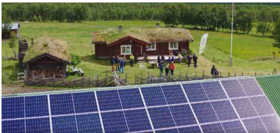
Det er til saman 48 solcellepanel på taket av seterfjøset (bilete: Norges Vel).
